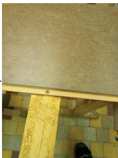
Detail ukotvení. Vrut do pera zahlouben. Z rubové strany obkladového panelu na vrutu nasazena distanční podložka (zatím matka, šlo by nahradit kroužkem, nebo něco obdobného) která umožňuje dotažení a nedeformuje pero pro další nasazení panelu
