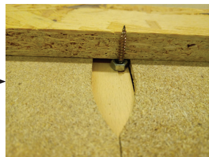
Detail ukotvení. Vrut do pera zahlouben. Z rubové strany obkladového panelu na vrutu nasazena distanční podložka (zatím matka, šlo by nahradit kroužkem, nebo něco obdobného) která umožňuje dotažení a nedeformuje pero pro další nasazení panelu
