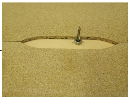
Detail ukotvení. Vrut do pera zahlouben. Z rubové strany obkladového panelu na vrutu nasazena distanční podložka (zatím matka, šlo by nahradit kroužkem, nebo něco obdobného) která umožňuje dotažení a nedeformuje pero pro další nasazení panelu
